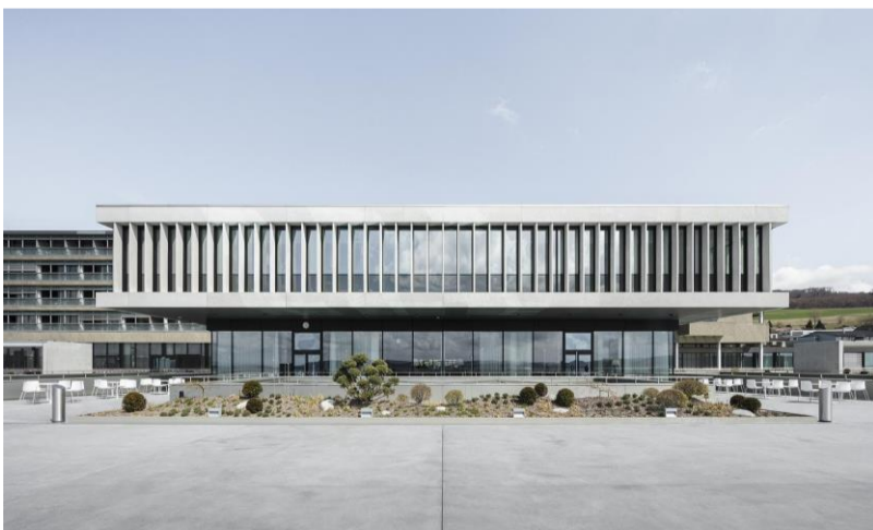
Quelle: Burkhardt + Partner Architekten AG, Zürich
